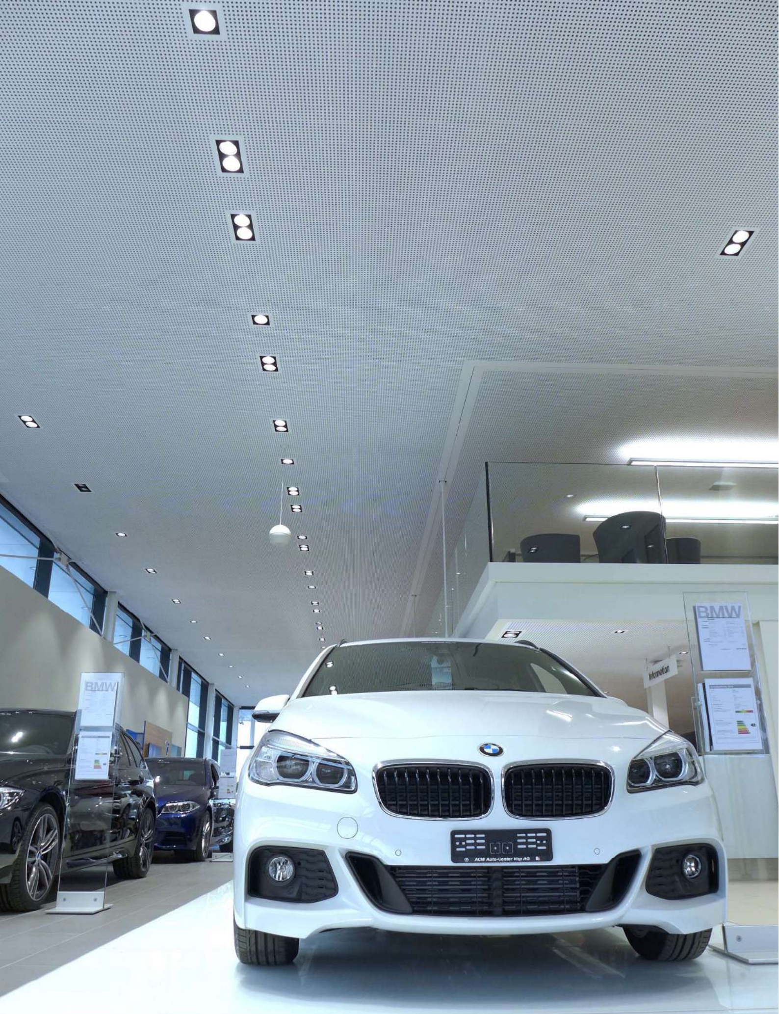
Перфорированный гипсокартон с акустической подложкой (ACW Auto-Center Visp AG)
