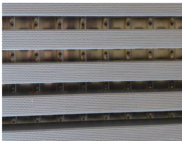
Акустические реечные панели из микроперфорированного металла.
