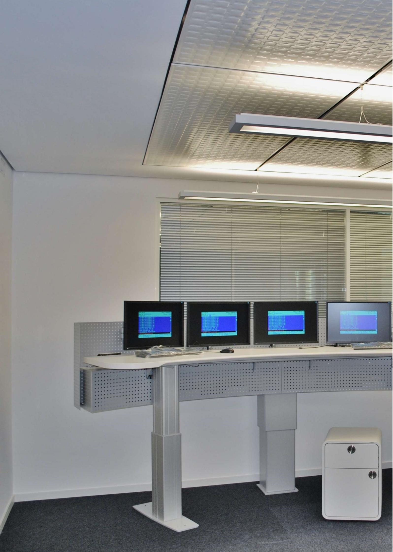
Акустические характеристики необработанной климатической панели Kigo сравнимы с акустикой деревянной или пробковой поверхности.
